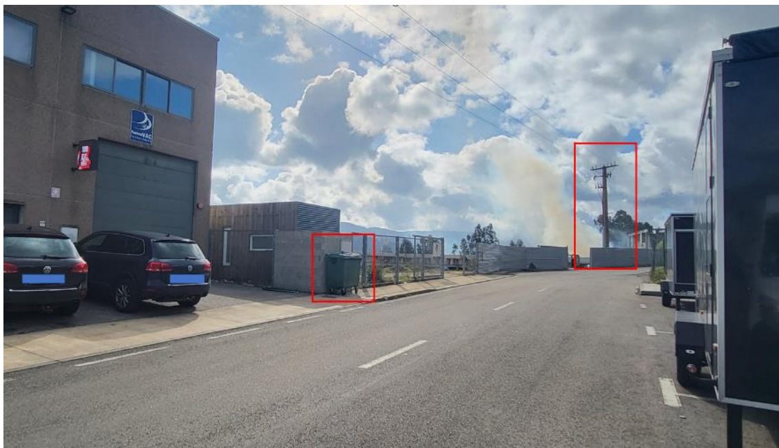
Figura 7. Contedor e liña eléctrica.
